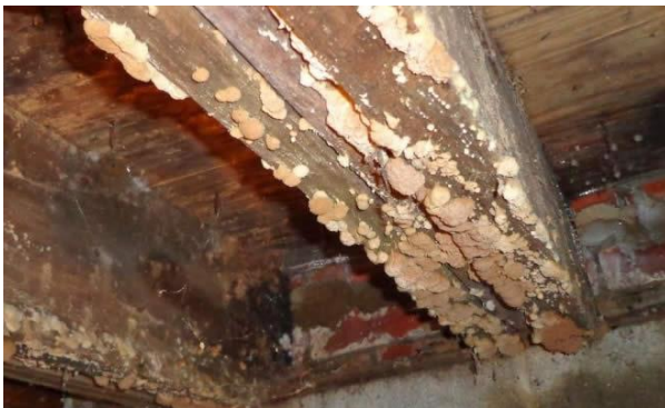
Zwamvorming op houten balken (Afbeelding: vochtbestrijding-experts.nl)
