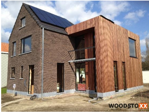
Hardstenen sokkel tegen opspattend vocht (Afbeelding: woodstoxx.be)
