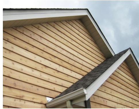
Dakoversteek beschermt de houten beplanking (Afbeelding: Thermowood.be)
