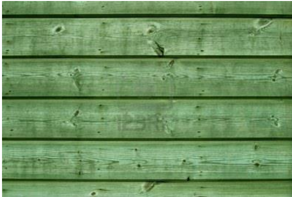
Chemisch geïmpregneerde planken (Afbeelding: woodtex.be)
