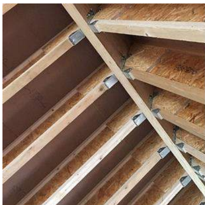
Hellend dak opgebouwd uit houten I-liggers in plaats van massief hout (Foto: craswoodshops.be)
