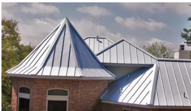
Complexe daken verliezen meer warmte dan daken met een eenvoudige vorm, foto Buldit
