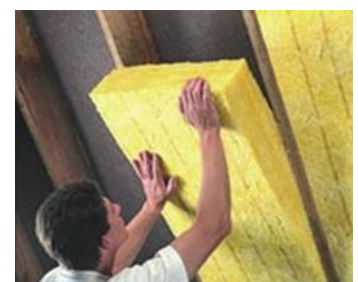
Spantendak isoleren (foto: Isover)
