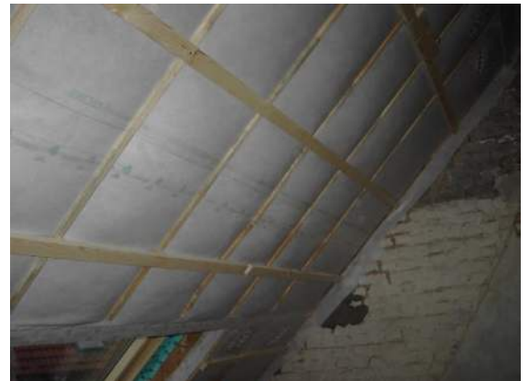
Luchtdicht afgewerkt hellend dak (Foto: E-advies)
