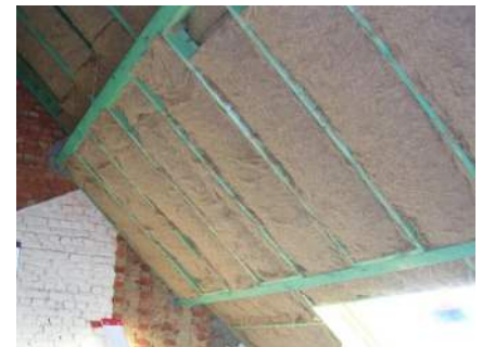
Isoleren van keperdak met drie lagen vlas (Foto: E. Willaert)
