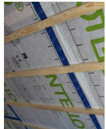
Luchtscherm plaatsen. (foto: arch. J. Van den Broeke)
