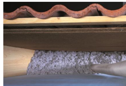
Isolatiemateriaal inblazen (foto: Isoproc)
