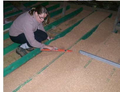
Zoldervloer isoleren met kurkkorrels (Foto: Recycork)
