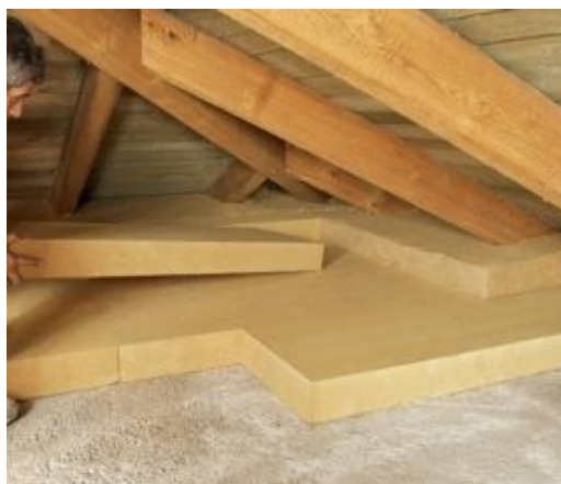
Drukvaste houtvezelisolatieplaten in twee lagen,
