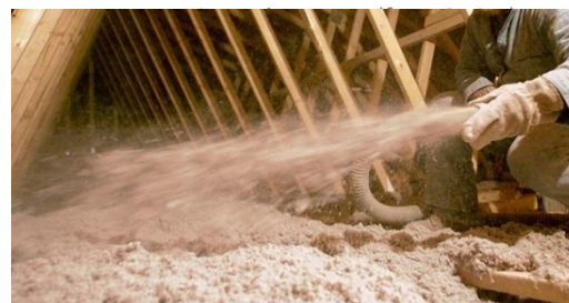
Papiervlokken open blazen bovenop de zoldervloer plaatsen: ontoegankelijke zolder (foto: isolatie-info.be)
