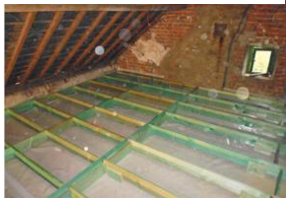
Plaatsen van een houten roostering op het luchtscherf, voor het aanbrengen van papierenvloekenisolatie (foto: Isolteam)
