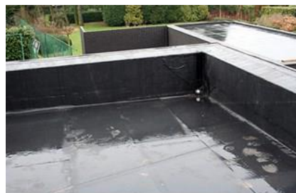
De dakrand moet minstens 15 cm boven het afgewerkte dakvlak komen, foto Livios
