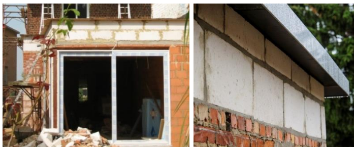
Verhoogde dakrand met cellenbeton en dakoversteek, foto links arch. D. Van Clé, foto rechts Lander Loecx
