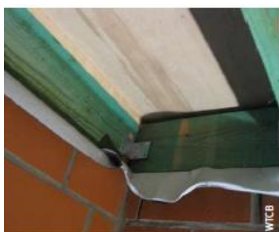
Luchtdichte aansluiting van warm plat dak met houten draagstructuur en spouwmuur met behulp van een wachtfolie 1. Afdichting 2. Dampscherm 3. Wachtfolie, foto en illustratie Buildwise
