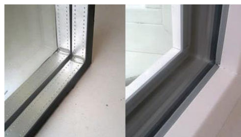
Aluminium afstandhouder (links) en isolerende afstandhouder
