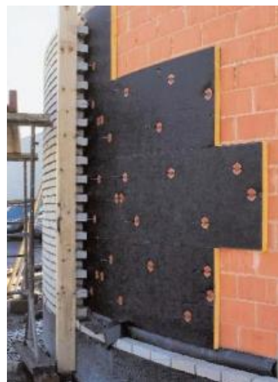
Gebogen wand met glaswolisolatie, foto www.baksteen.be
