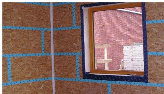
Luchtdicht afgewerkte OSB-platen, foto arch. E. Willaert
