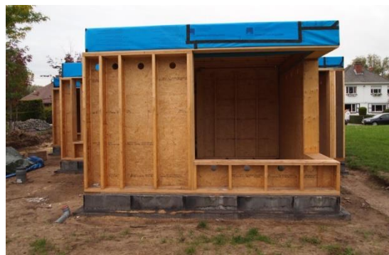
Uitvoering van de draagstructuur en de uitstijvende platen, foto passiehuis St.-Amandsberg
