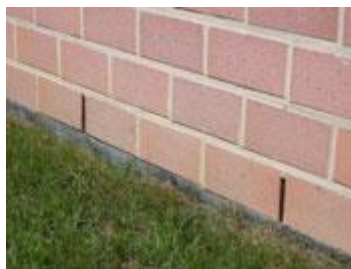
Halfsteens metselwerk met open stootvoegen en waterkering onderaan de spouwmuur, foto Buildwise
