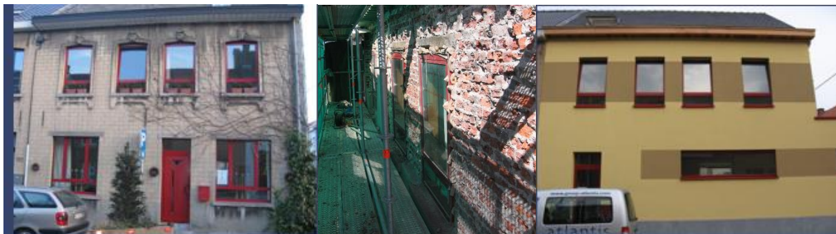
Woning in Halle. Links: oorspronkelijke voorgevel – midden: afbraak van het gevelmetselwerk – rechts: buitenisolatie met gevelpleister, foto's Christel Geeraerts en Marc Tanghe
