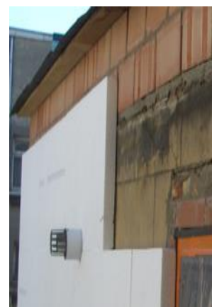
Gevelisolatie met EPS-platen, foto LEHR
