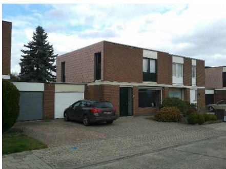
Gevelisolatie met steenstrips, foto's De Jaegere JP architectenbureau
