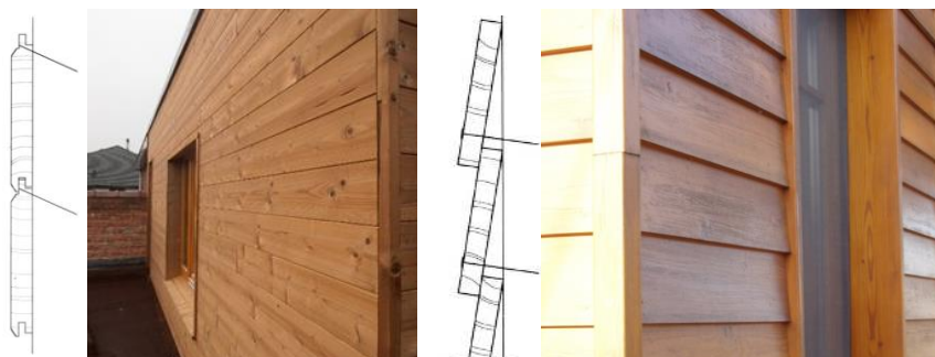
Horizontale gevelplanken met tand en groef, foto arch. E. Willaert
