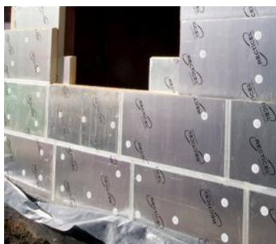
2 e laag isolatieplaten met afgekleefde naden
