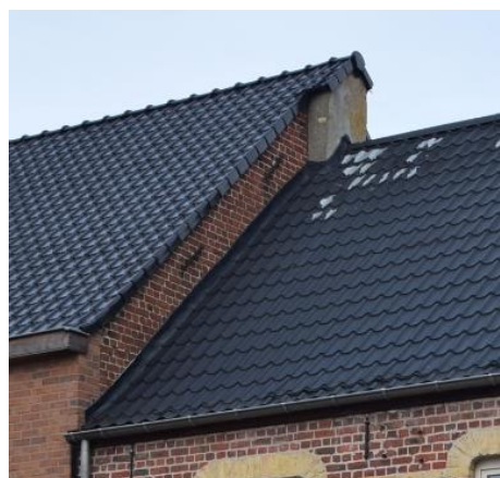
Niet-geïsoleerde muur op de perceelsgrens, boven het lagergelegen dak, foto Diksimmo
