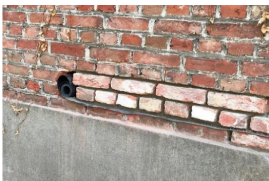
Onderkappen van een muur en de plaatsing van een waterkering om opstijgend vocht tegen te gaan. (Foto: murenvchtig.be)
