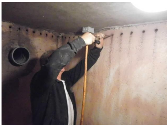
Injecteren ter hoogte van de bovenkant van een kelder muur, net onder de vloerconstructie. (Foto: meesterklusser.be)
