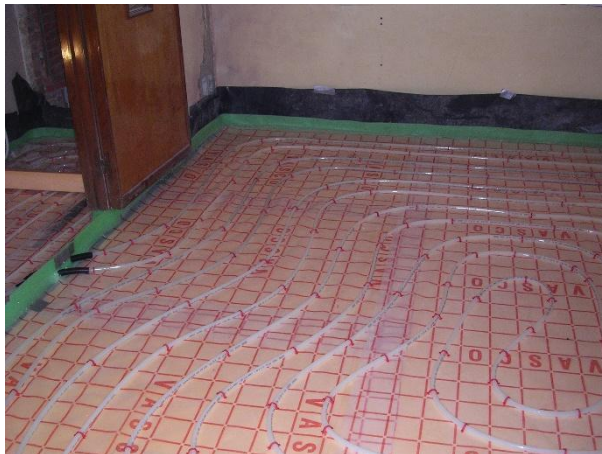
Drukvraste XPS-vloerisolatie, vochtmembraan, vloerverwarming met tackers vastgezet (foto: Evelien Willaert)
