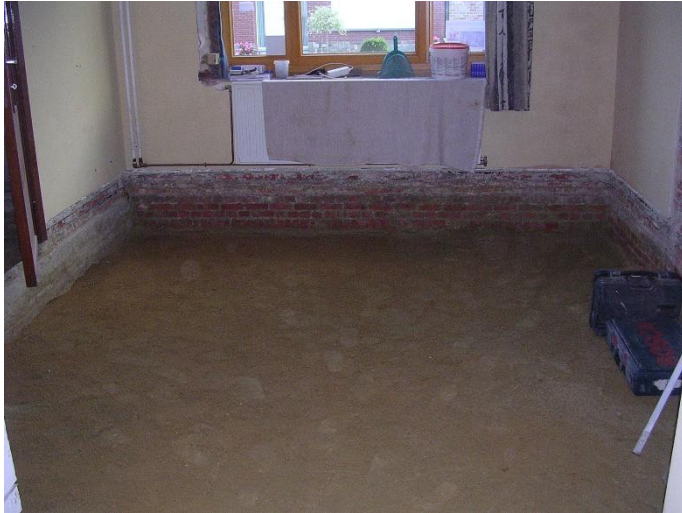
Voldoende diep uitgraven van de vloer. (Foto: Evelien Willaert)
