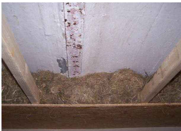
Isoleren tegen de onderzijde van een gewelfd plafond met soepele isolatiematerialen. (Foto: Easyhemp)
