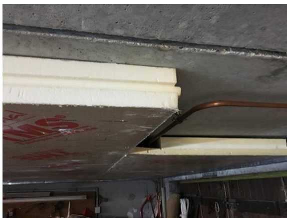
Uitsparing in de isolatie voor buizen. (Foto: Cap Habitat)
