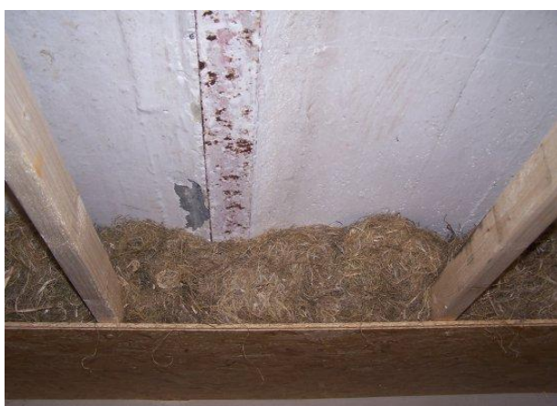
Isoleren tegen de onderzijde van een gewelfd plafond met soepele isolatiematerialen. (Foto: Easyhemp)
