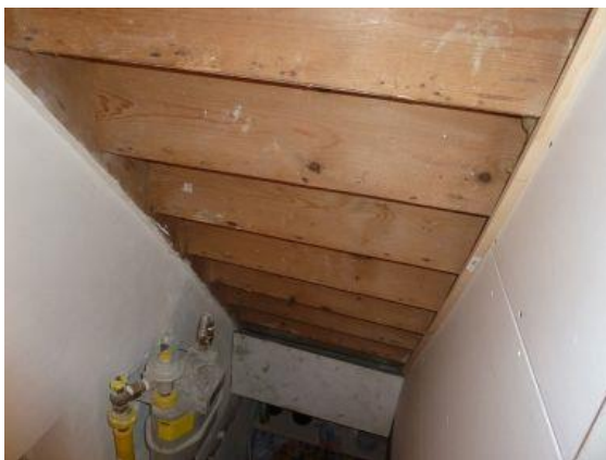
Een houten trap boven een keldertrap die enkel uit houten planken bestaat, isoleer je via de onderzijde. (Foto en illustratie: Klusidee)
