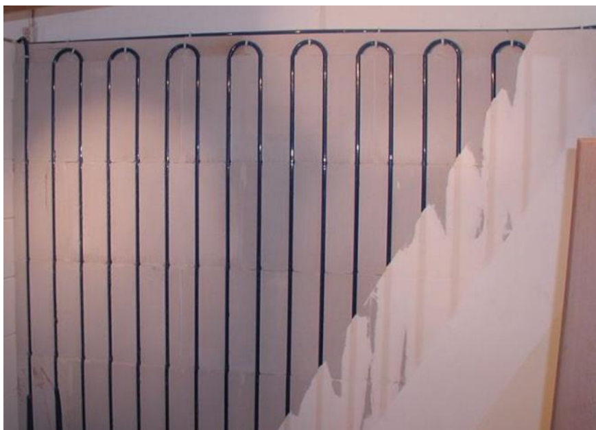
Muurverwarming bij blokken met ingewerkte sleuven (Bron: duurzaamtextel.nl)
